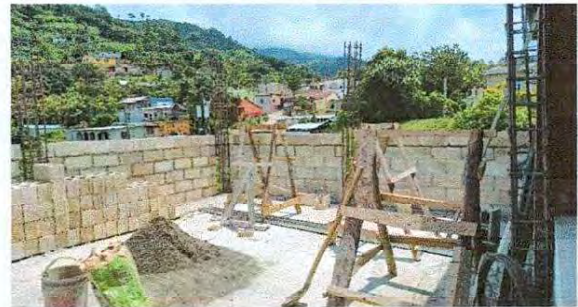
Foto 8: Remodelación de aula 2, segundo nivel del edificio escolar
