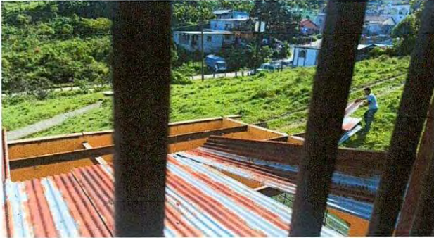
Foto1: Se inició a quitar el techo del salón 1 en el que se reforzarán las paredes que sirven también como muro perimetral.
