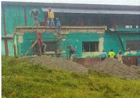
Foto 7: Fundición de la losa.
