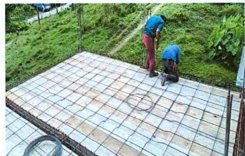
Foto 6: Colocación de los hierros y las vigas para completar una losa.
