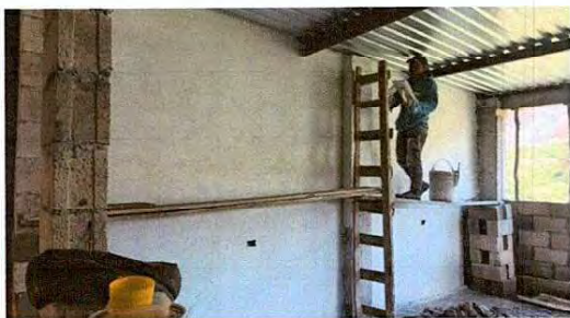
Foto 11: Aplicación de monocapa en las paredes priorizadas.
