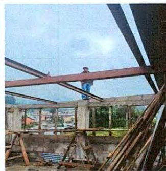
Foto 10: Colocación de la estructura metálica para el entechado del salón segundo nivel.
