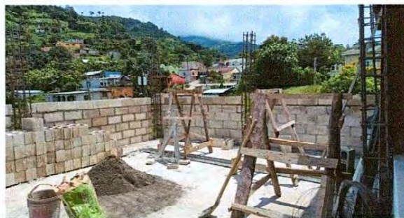
Foto 8: Remodelación de aula 2, segundo nivel del edificio escolar
