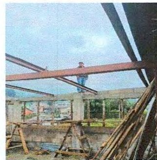
Foto 10: Colocación de las estructura metálica para el entechado del salón segundo nivel.
