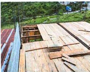
Foto 5: Encofrado para la completación de losa
