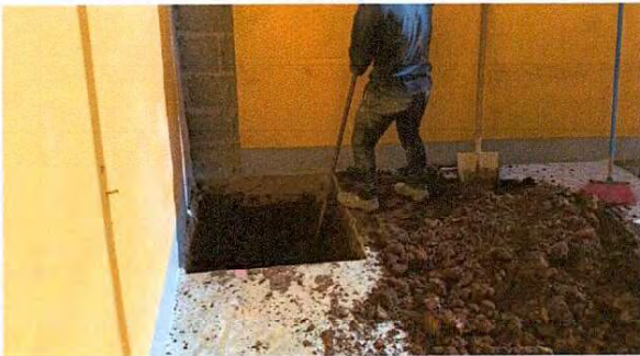
Foto 3: Se inició con la excavación para la cimentación de las columnas que reforzarán los muros y la completación de losa.
