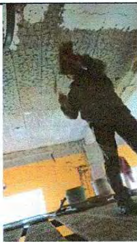
Foto 9: Mantenimiento de la losa con la aplicación de material para acabado final.
