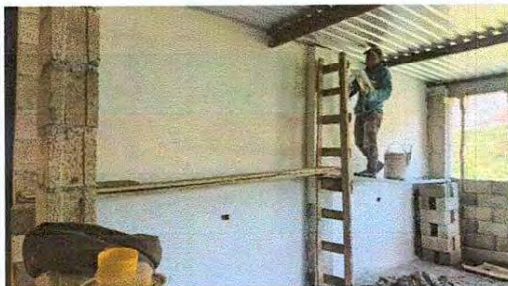
Foto 11: Aplicación de monocapa en las paredes priorizadas.
