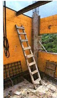
Foto 4: Colocación de las estructuras de hierro y fundición de las columnas de reforzamiento de las paredes que sirven como muro perimetral y que servirán para la completación de losa.
