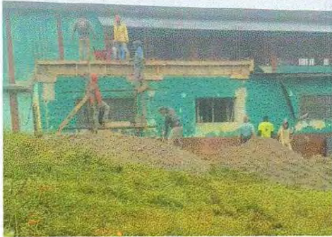
Foto 7: Fundición de la losa.
